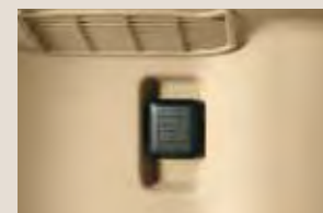
Tomacorriente en el compar- timiento para el equipaje
